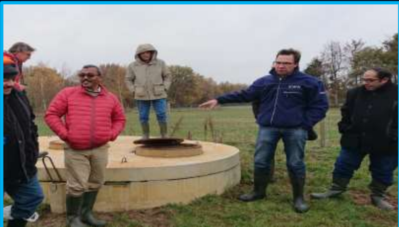
خزان تجميع المياه المعالجة
