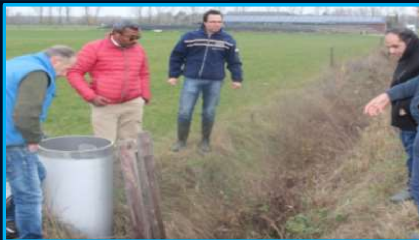
غرفة تفتيش مصب المجمع
