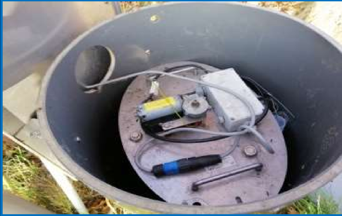
غرفة تفتيش مزودة بجهاز تحكم في مستوى الماء الارضي
