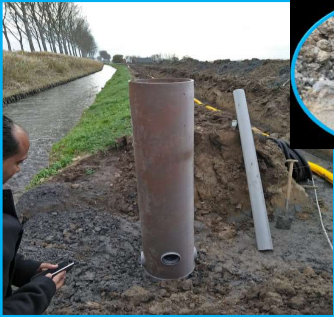
غرفة مصب تزود بنظام تحكم و طلمبة رفع
